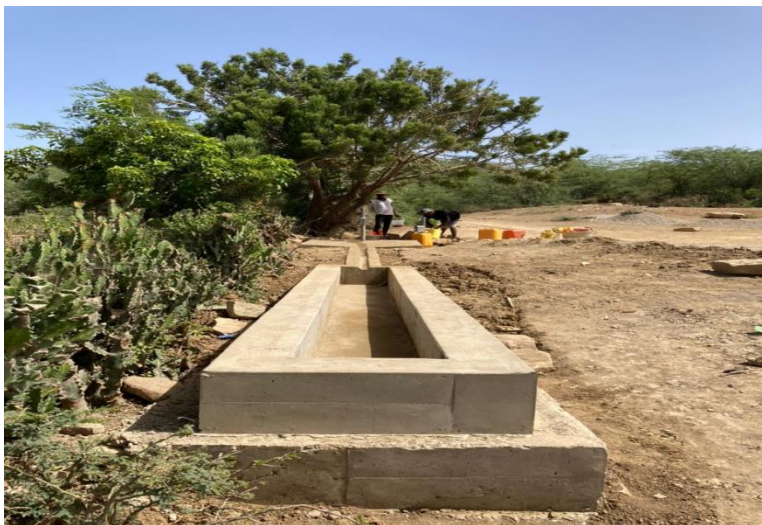
Photo d'Abreuvoir-type construit dans le cadre du MYP5
