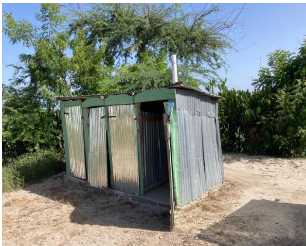
Photo : Etat d'une latrine avant intervention
