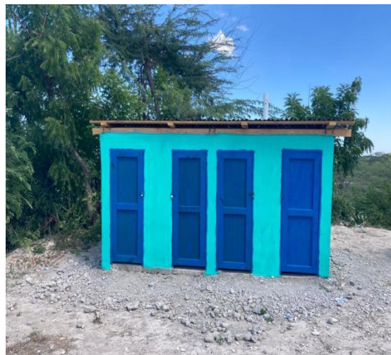
Photo d'une latrine après intervention
