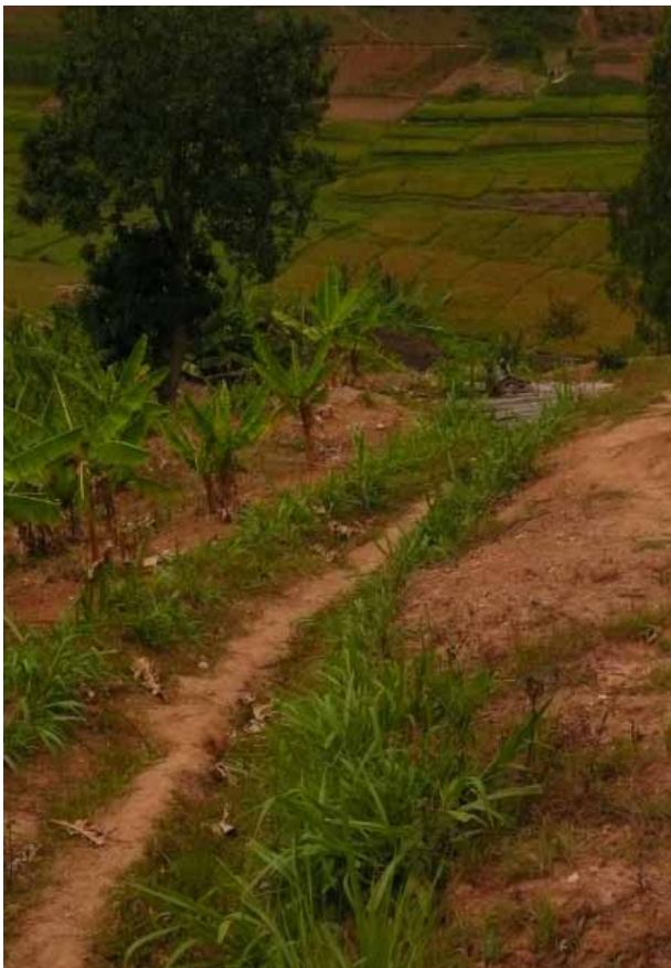
Rwanda, passage d'eau de pluie vers puits perdu (PROTOS).
