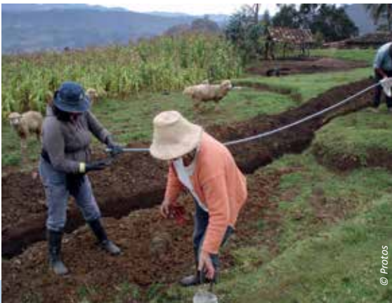
La population aide à creuser les tranchées.
