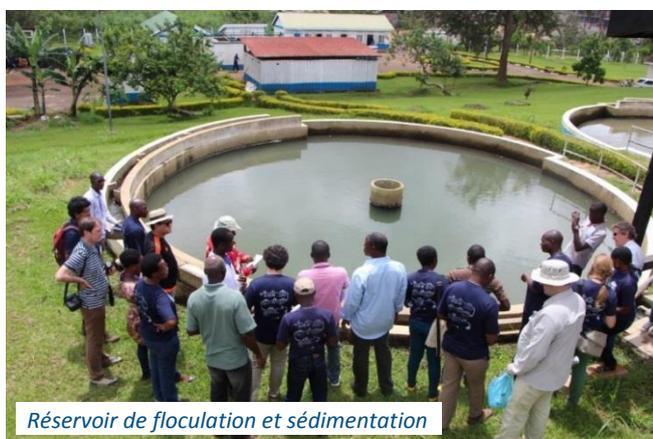
Réservoir de floculation et sédimentation
